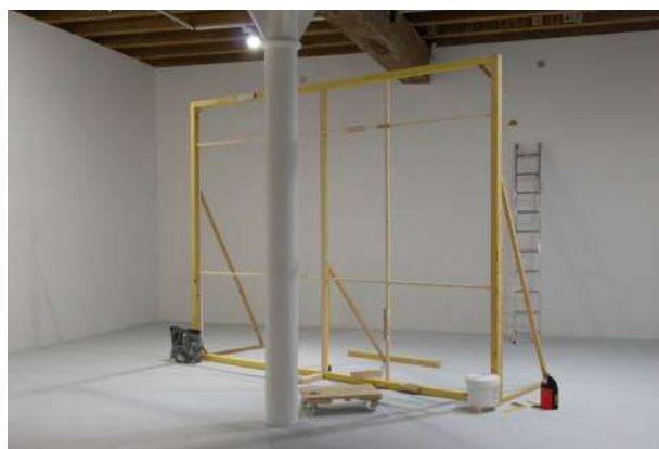
Montage en cours, Vidéochroniques, janvier 2023
